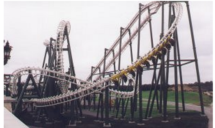
Achterbahnfahrweg als Schweißkonstruktion.
